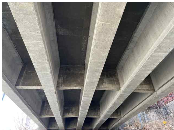
거더 및 바닥판하면 전경
