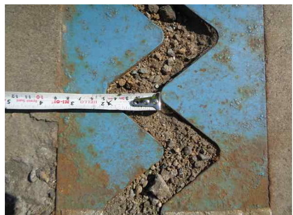
신축이음 이동량 측정
